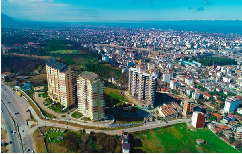
پروژه مسکن بام چالوس
